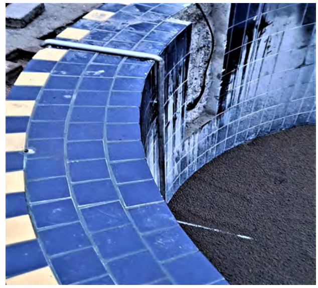
Altaaseen asennettiin poistoputki kondenssiveden poistoon vanhan ja uuden altaan välitilasta pohjalta.
