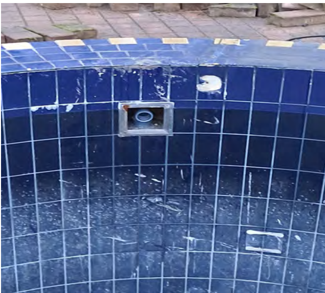
Vanhan kaakelialtaan ylijäämäveden poistoputket modifioitiin HPK®HST altaalle sopiviksi
